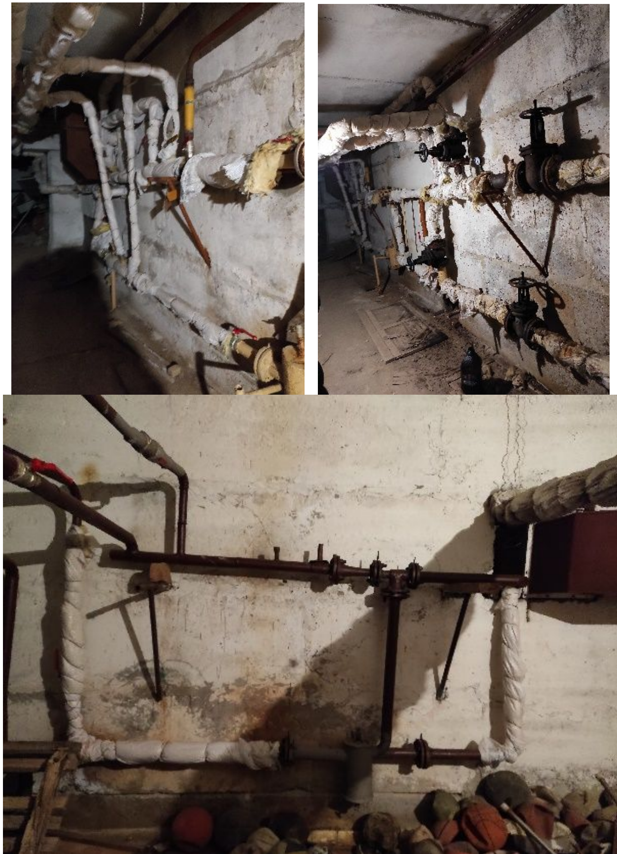
Рис. 2 Індивідуальний тепловий пункт корпусу «Ф» з двома елеваторними вузлами
