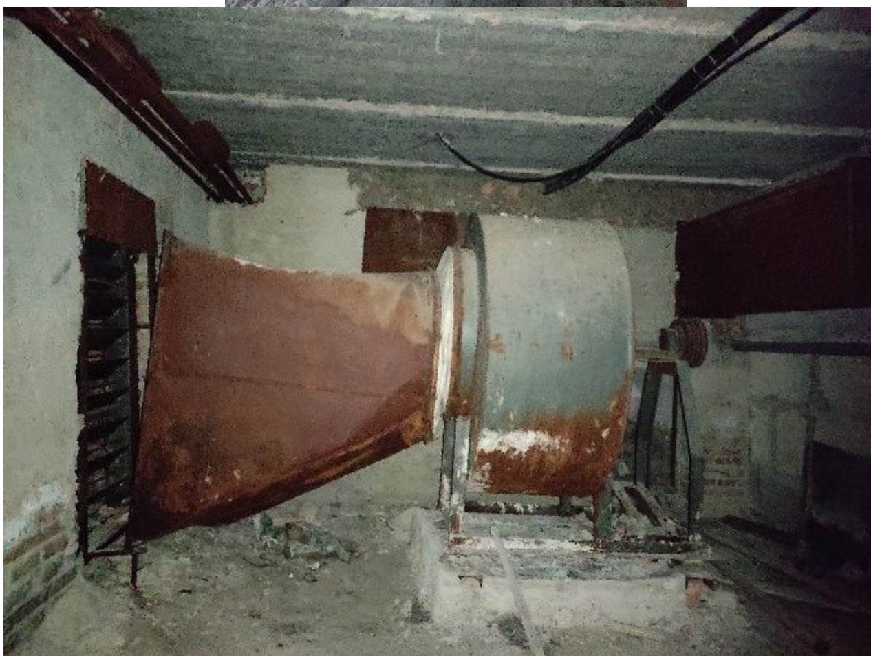
Рис. 3 Стан елементів централізованої припливної камери
