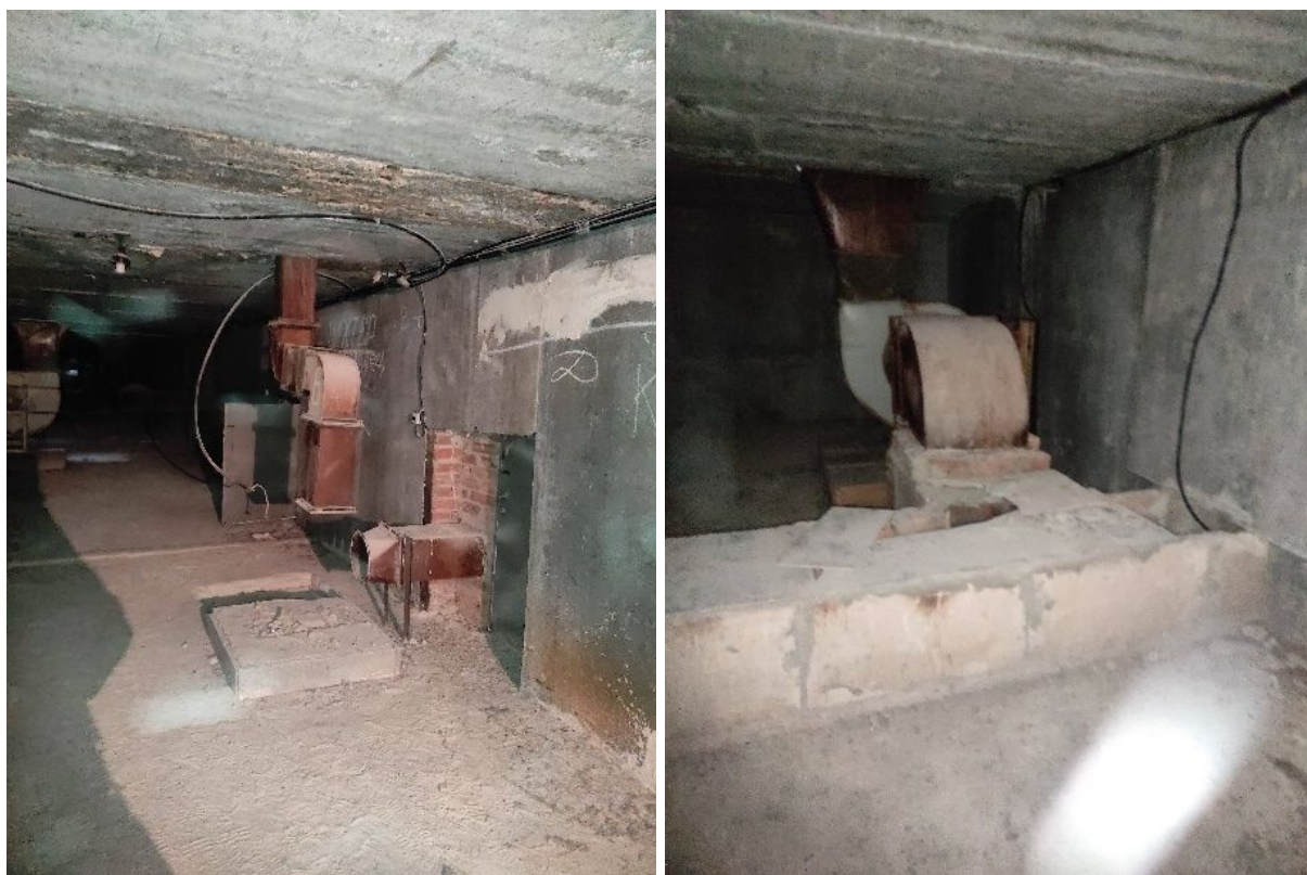
Рис. 7 Залишки механічних витяжних систем вентиляції (до реконструкції)
