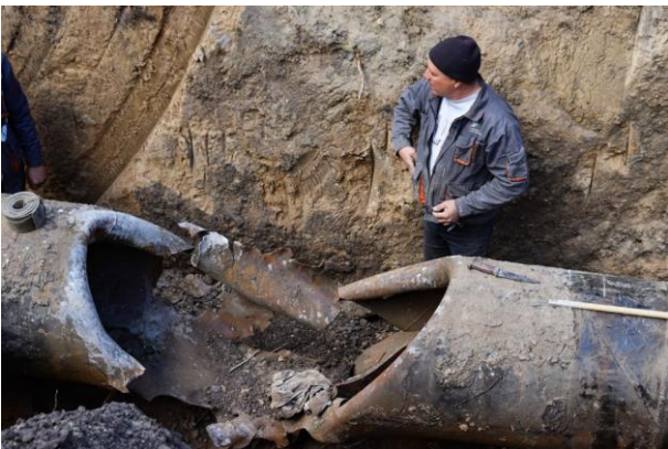
Рис. 7. Ремонт пошкодженого газопроводу
