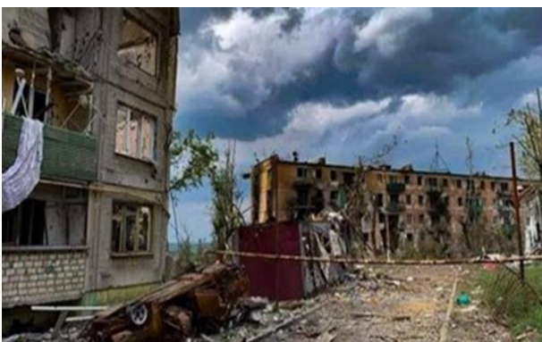
Рис. 3. Руйнування газифікованих багатоповерхових будівель
