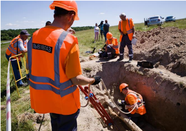
Рис. 9. Розкриття контрольних шурфів
