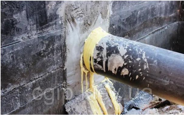
Рис. 12. Ввід інженерних мереж в будинок
