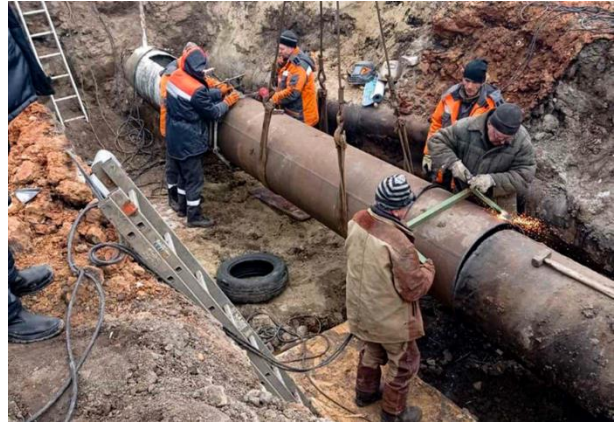
Рис. 8. Зварювання котушки в підземний газопровід
