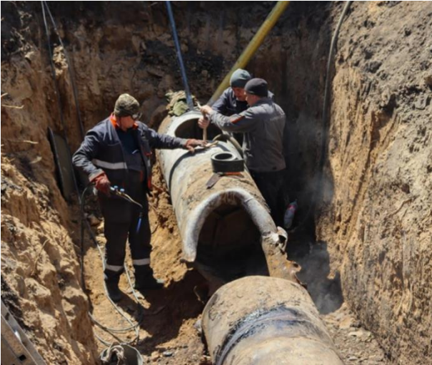
Рис. 6. Розкопка пошкодженого газопроводу
