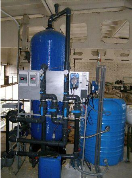
Рис. 6. Установа хімічної дегазації води Redox-KM
