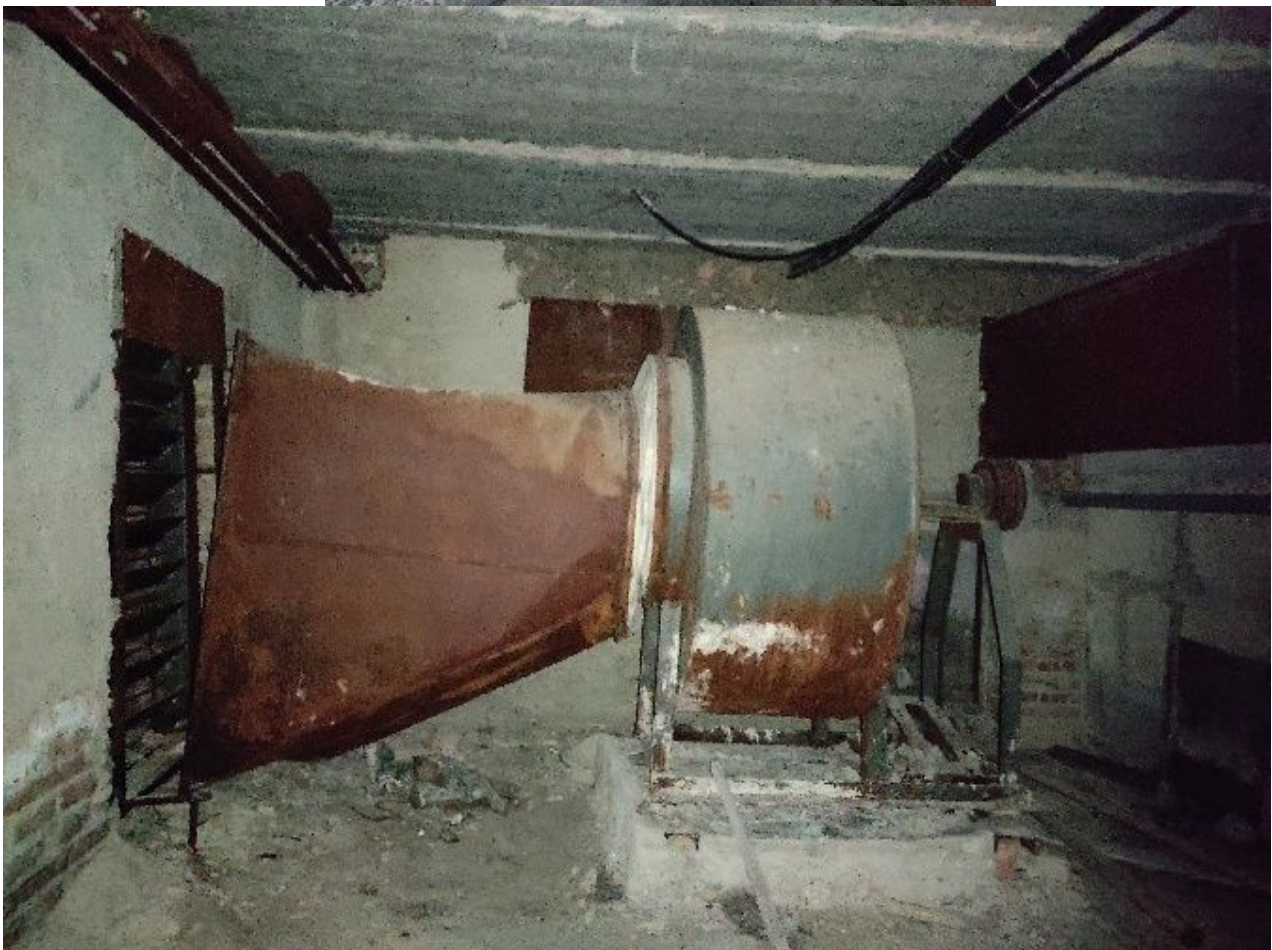
Рис. 3 Стан елементів централізованої припливної камери
