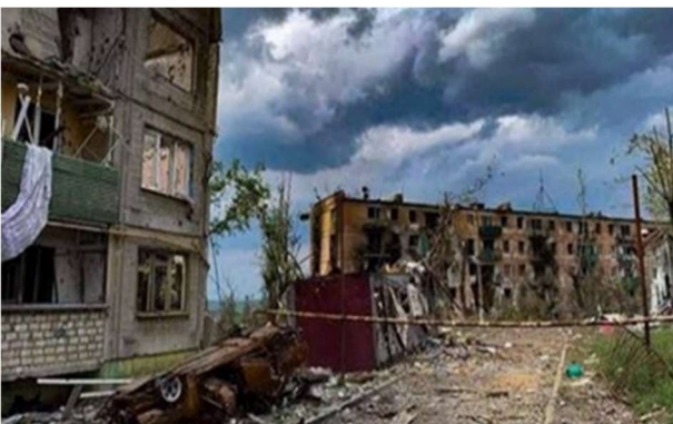
Рис. 3. Руйнування газифікованих багатоповерхових будівель
