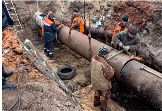
Рис. 8. Зварювання котушки в підземний газопровід
