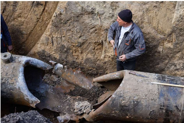
Рис. 7. Ремонт пошкодженого газопроводу
