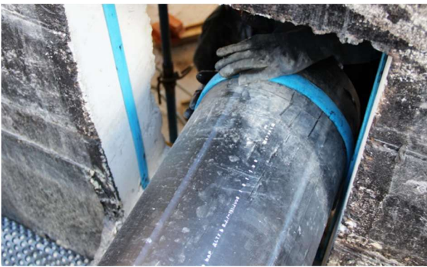
Рис. 13. Ущільнення вводів в будинок
